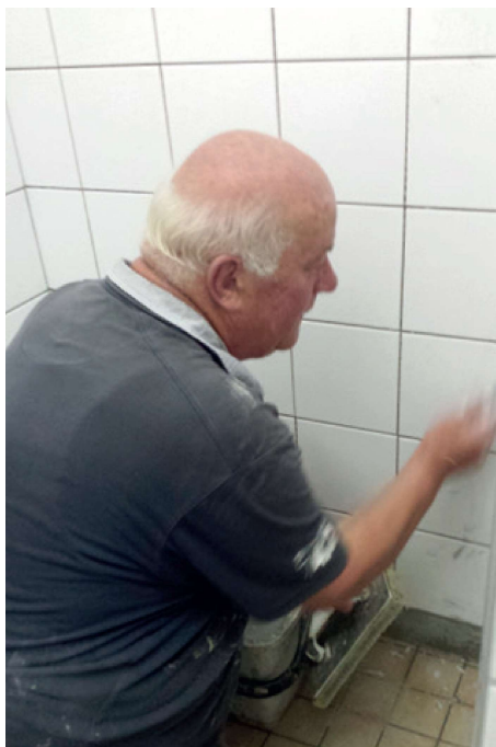
ondergrondse Harrie (renovatie)
